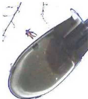
Accumulation de boue en fond de vasque
