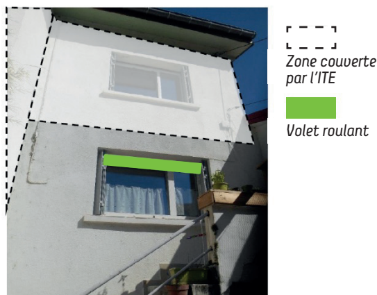
Façade sud : après travaux
